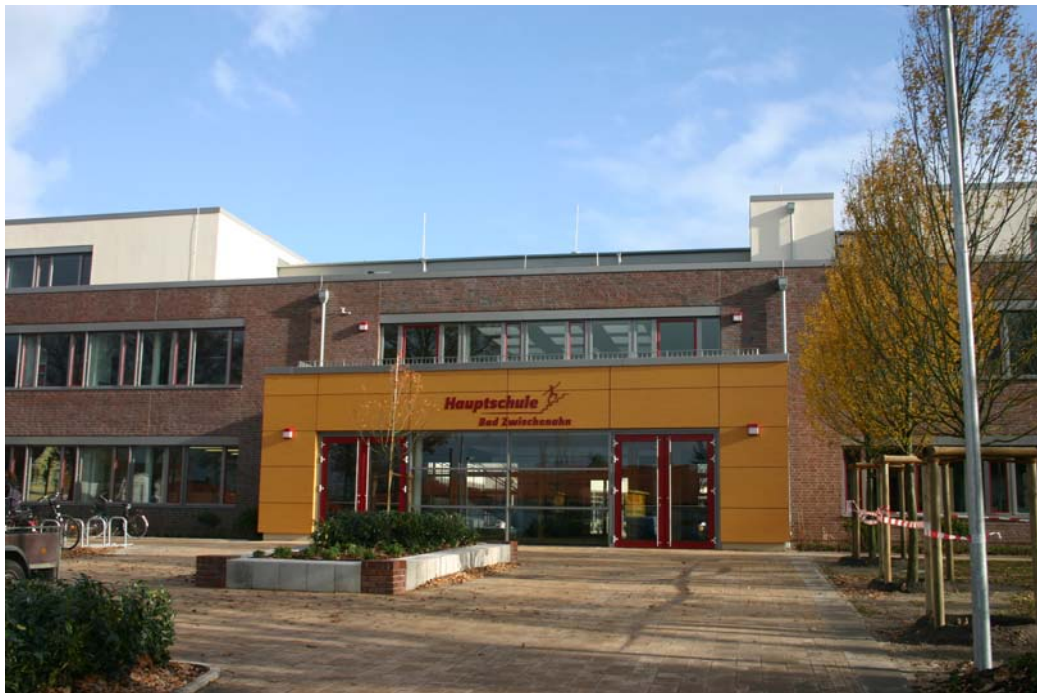
Foto: Hauptschule Bad Zwischenahn, Am Reihdamm
